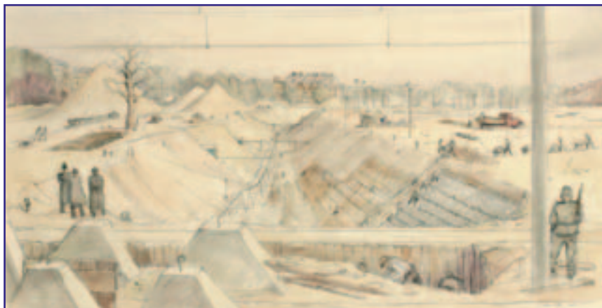
Aanleg anti-tankgracht bij Stadsbouwersplein, 1943. Tekening Cbr. Schut.
